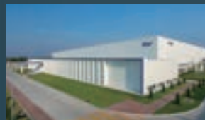
稼働開始に向け準備が進む工場棟
