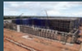
建設中の工場棟
